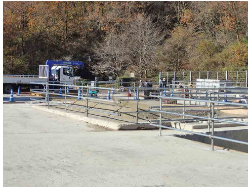
換気立坑埋め戻し完了
