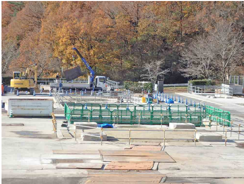
主立坑埋め戻し完了
